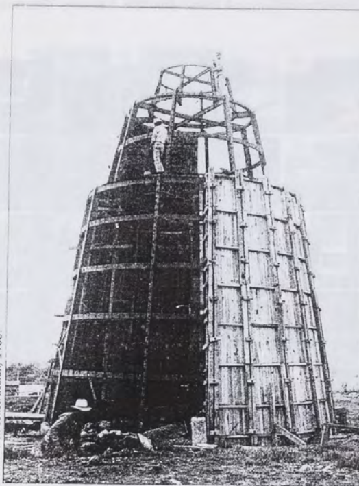
La torre en construcción, 1968.
