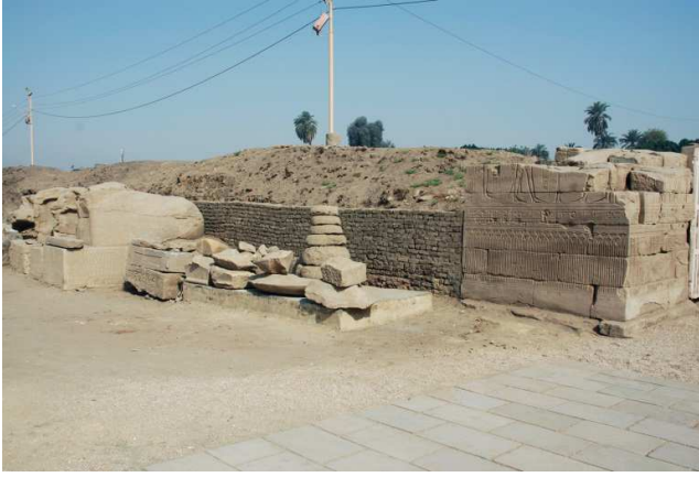
شكل ١٧ الوجهة الداخلي للحائط السياجي الشمالي المعاد بناء غرب الصرح الأمامي والمصطبة.
